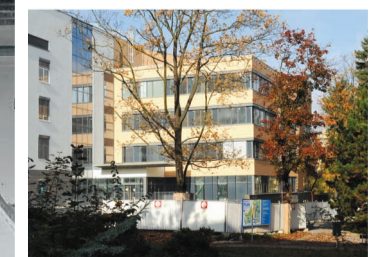
Novostavba Centra akutní medicíny bude hotová začátkem příštího roku.
