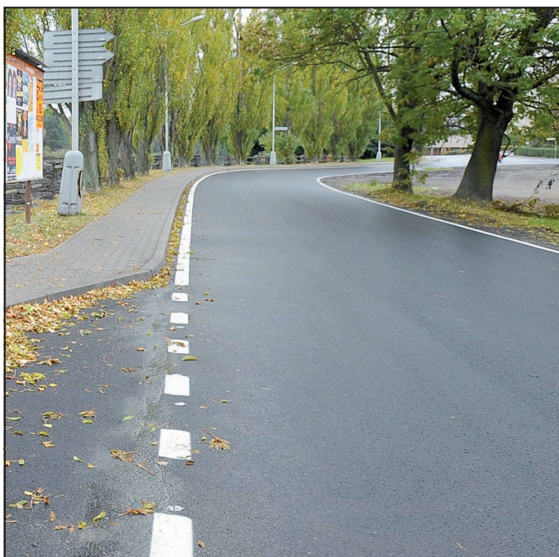
V Čáslavi mají opravený zhruba kilometr úsek průtahu městem. Jde o silnici č.II/338. Na opravovaném úseku došlo k frézování povrchu vozovky, k položení vyrovnávací a obrusné vrstvy, k opravě krajnic, čištění příkopů a umístění vodorovného dopravního značení. Celkové náklady oprav, které v plné výši hradil Středočeský kraj byly 15,9 milionů korun.
