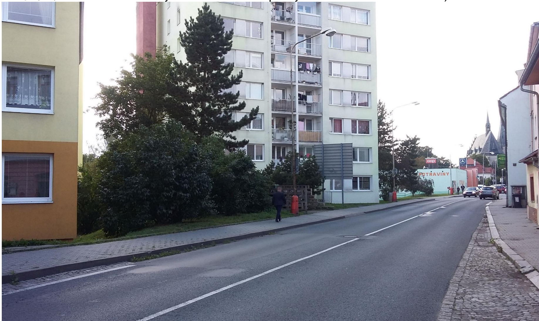
Obr. 18: Fotodokumentace zástavby v okolí kritického místa priority I ve městě Rakovník - ulice Pražská, komunikace II/227
