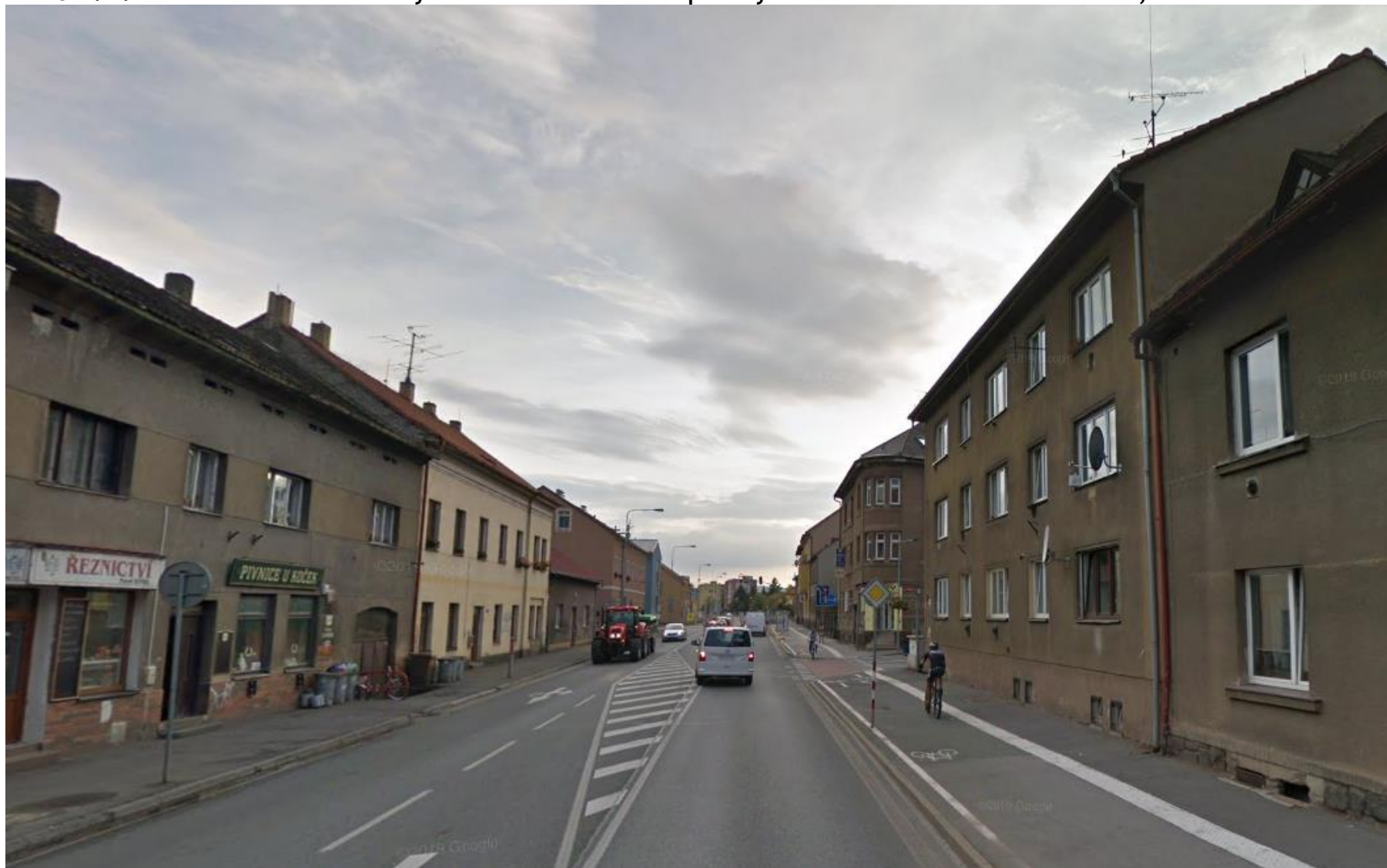
Obr. 6: Fotodokumentace zástavby v okolí kritického místa priority I ve městě Beroun - ulice Plzeňská, komunikace II/605
