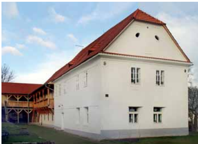
Ledčice, statek U Cinků čp. 15 – po obnově, okr. Mělník
