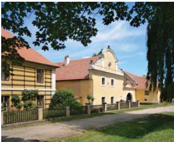
Třebíz – Šubrtův a Cífkův statek, okr. Kladno
